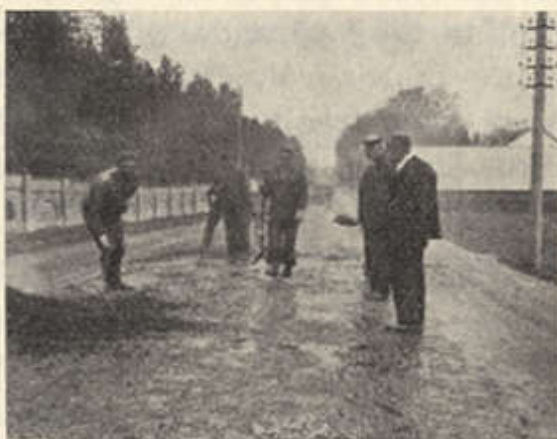
Bituumendatud makadam-teeosa parandamine Narva maanteel.
