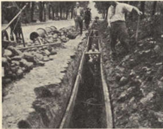
Kanalisatsiooni ehitamine J. Kuperjanovi tänaval.
