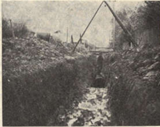
Kanalisatsiooni ehitamine Vaba tänaval.
