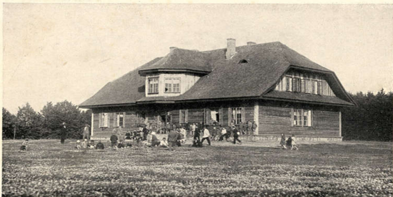
Kaagvere lastekodu paviljon.
