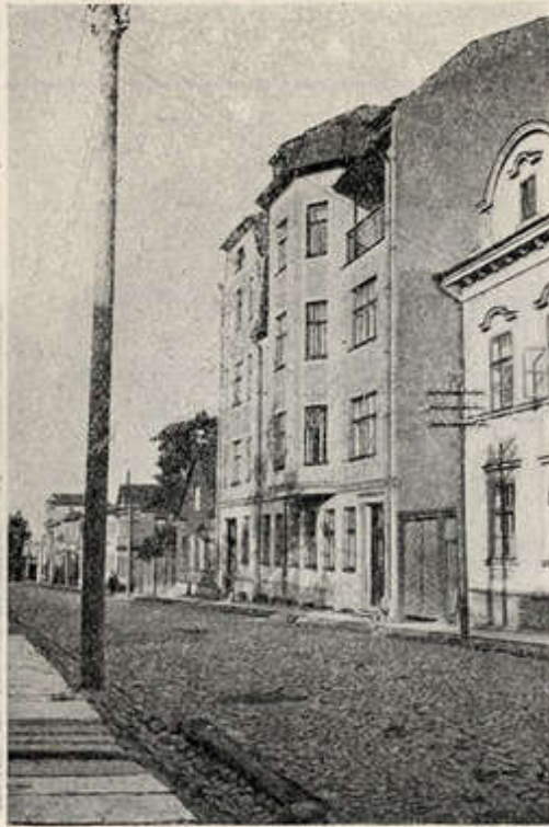
44. joon. Mansardpüstik Toomitaguses. Maison-type moderne: haute maison oblongue avec avant-corps à deux pans de comble en mansarde.
